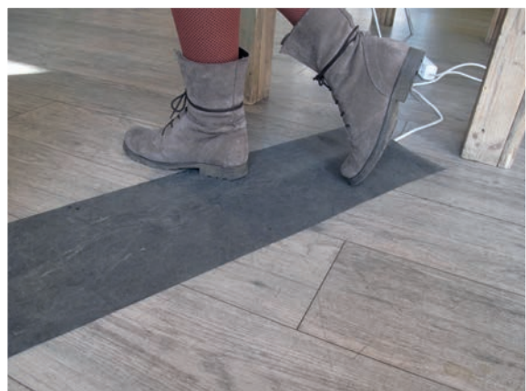
Veilig: snoeren afgedekt met kabelmatten
